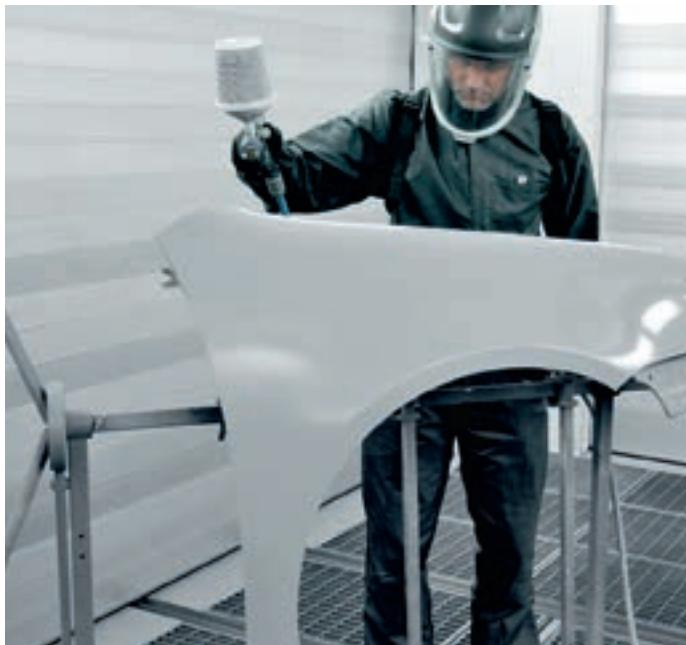
Ao utilizar o NS2081 – NS2084 – NS2087 Ultra Performance Non-Sanding Surfacer, poderá pintar peças novas mais rápido do que nunca. Graças à tecnologia patenteada da Axalta, o tempo de evaporação é significativamente reduzido em comparação com os aparelhos sem lixagem convencionais – o que significa resultados mais rápidos para a oficina.
